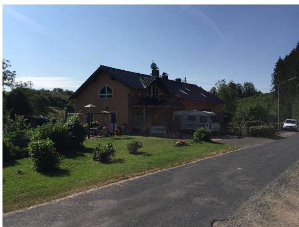
Blick von Norden auf das Wohngebäude
