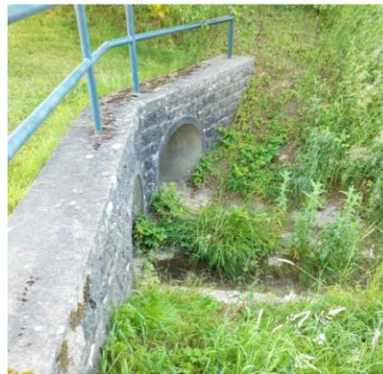
Foto 12: Verrohrung des Nüßbachs und des Grabens unterhalb der Kleebachstraße<sup>26</sup>
