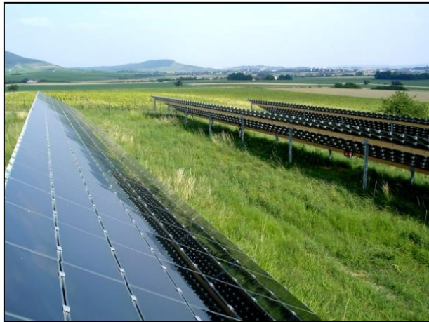
Abb. 3: Beispiel für eine aufgeständerte Anlage mit Unterwuchs
